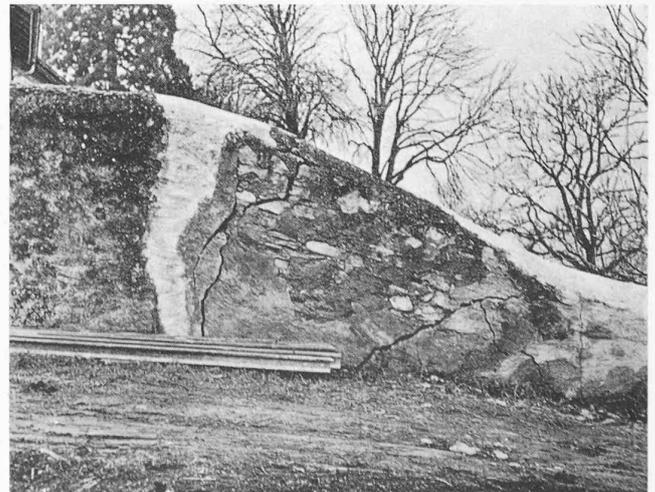
Fig. 7. — Chancy. Mur déformé par les glissements de terrain, rive suisse.
