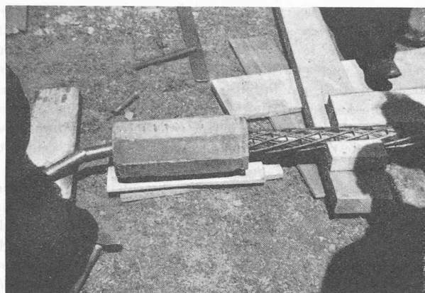
Fig. 9. — Système Shorer-Chalos. En haut : schéma. En bas : Les fils constituant le câble viennent d'être libérés, le noyau articulé peut être récupéré.
