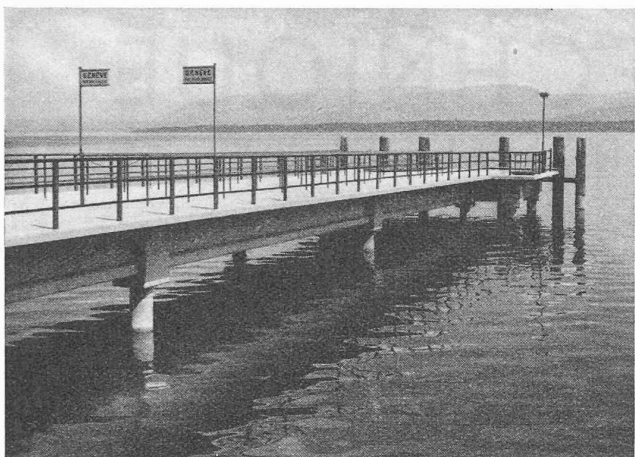
Fig. 2. — Vue d'ensemble du nouveau débarcadère.
