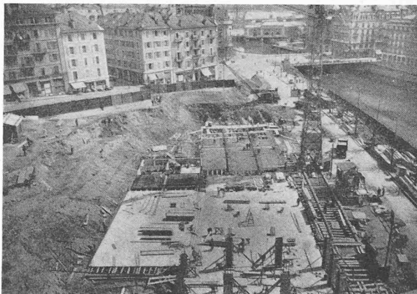
Fig. 1. Vue d'ensemble des fondations en cours d'exécution.
