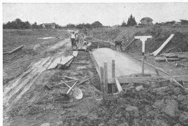
Fig. 8. — Etalement du chantier.
