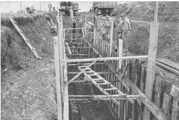
Fig. 5. — Terrassement en fouille ouverte.
