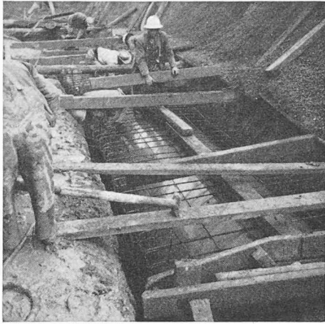
Fig. 3. — Calage du « ductube ».
