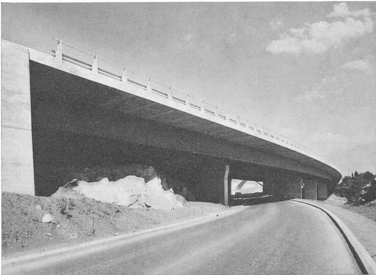
Fig. 1. — Les ponts de la Salenche surplombant la correction de la route cantonale 763. La vue est prise en direction de Chardonne.
