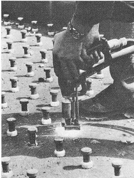
Fig. 20. — Exemple de connecteurs — à goujon.
