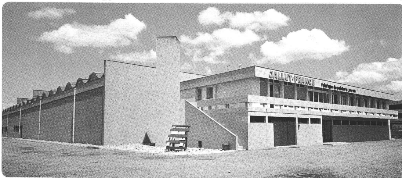
Usine JALLUT-FRANCE S.A., Annemasse
