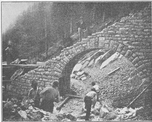
Fig. 10. — Voûte sur la « Charrière ».
