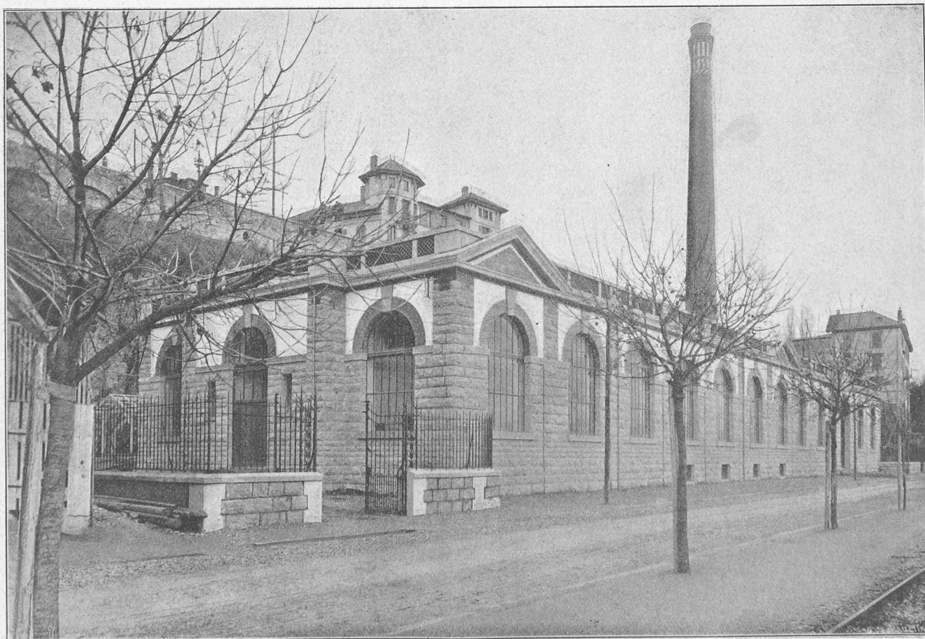
Fig. 1. — Usine électrique à vapeur de Neuchâtel. — Vue du bâtiment.
