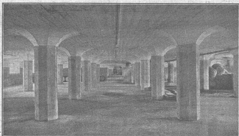
Plancher sans nervures, système Maillart. — Sous-sol d'entrepôt.
