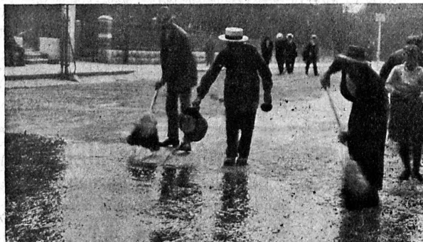
Bimoïdage d'une chaussée goudronnée
