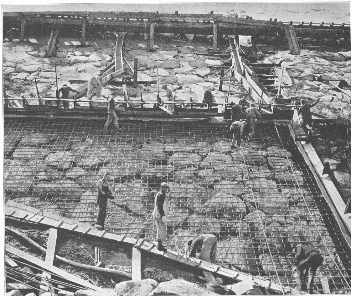
Fig. 10. — Vue de l'armature du masque. Le béton est coulé sur les blocs de rocher mis en place par le derrick. Chaque panneau de 18,29 m × 18,29 m est fait d'une seule coulée.
