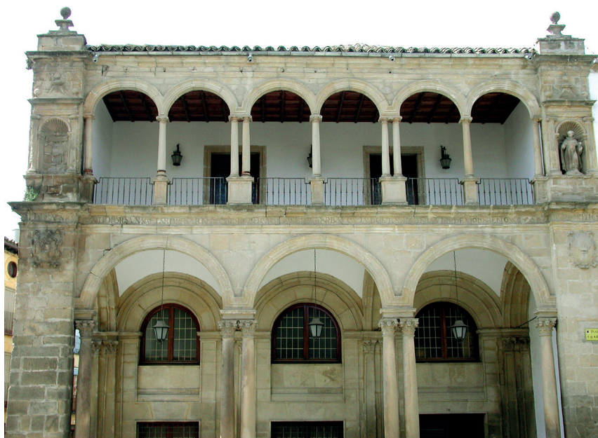
Figura 2.–Galería alta de las Antiguas Casas Consistoriales.
