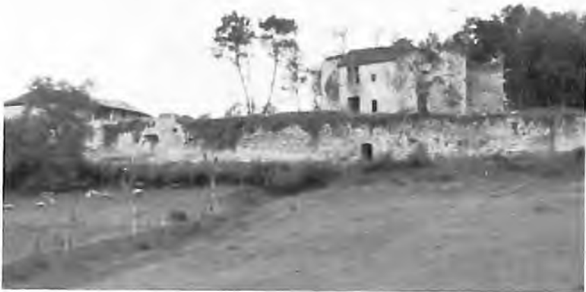
Le château sur sa terrasse. Au centre du mur, l'entrée du souterrain-refuge.
